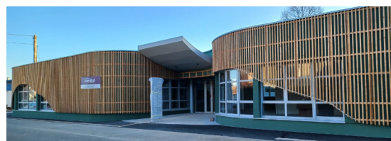
Fin des travaux (2026)
