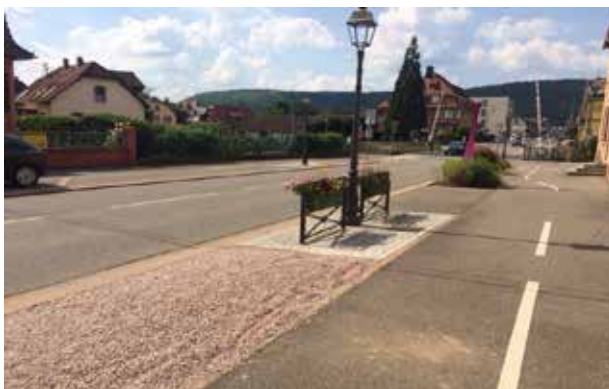
Réaménagement de massifs et remplacement de mobilier urbain
